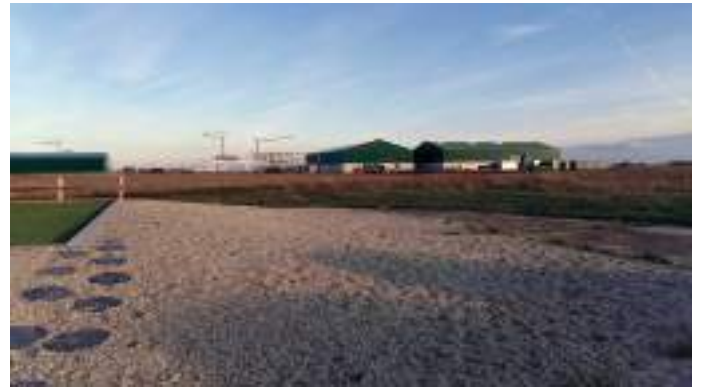
Chantier TSF, constructions autorisées par un permis de construire précaire octroyé le 29/09/2023 © Jane Buisson
